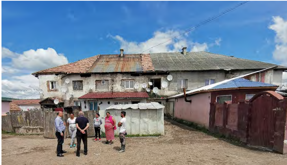
Figura 88: Fost bloc de locuințe pentru muncitori, actualmente „privatizat”
