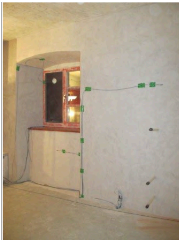
Figura 59: Senzori aplicați pe tencuială
