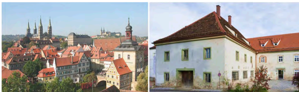
Figura 58: Mănăstirea benedictină din Bamberg, Germania. Aplicarea unui mortar izolant și monitorizarea comportamentului energetic al clădirii în timp, proiectul EFFESUS
